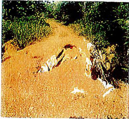
Jambatan pertama yang runtuh
